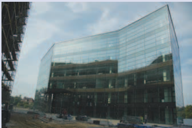
Fot. 1. Elewacja słupowo-ryglowa
