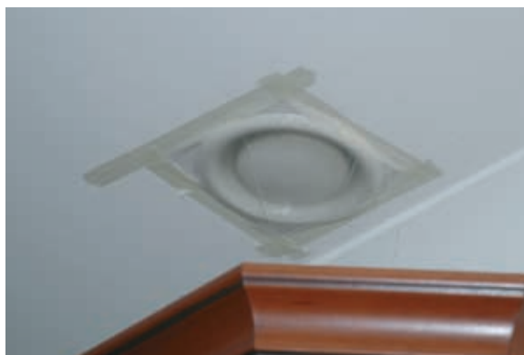
Fot. 6. Przykład zaślepienia anemostatu
