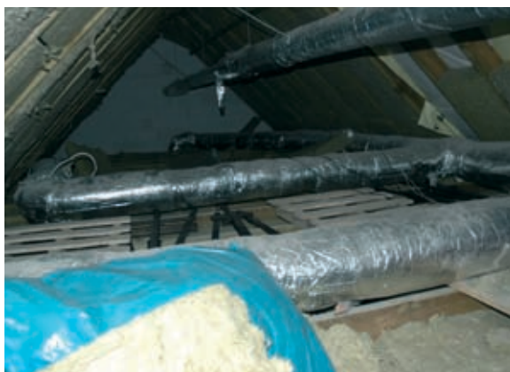
Fot. 2. Rozprowadzenie instalacji wentylacji mechanicznej na poddaszu
