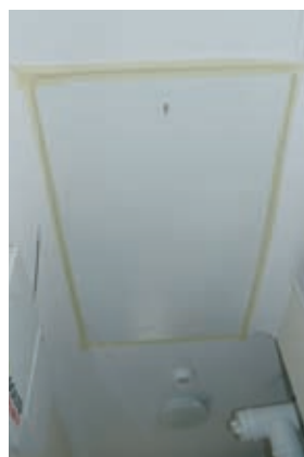
Fot. 8. Uszczelnienie włazu na poddasze
